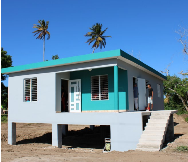
Casa reconstruida en Loíza.
